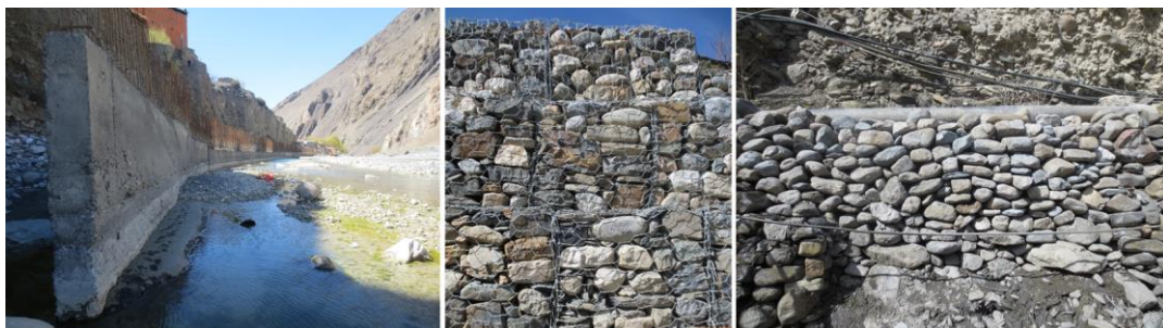
Abb. 3: Technische Schutzmaßnahmen (Zementmauer, Gabione, Trockenmauer) (Foto: R. FLEISCHMANN, 2013)
